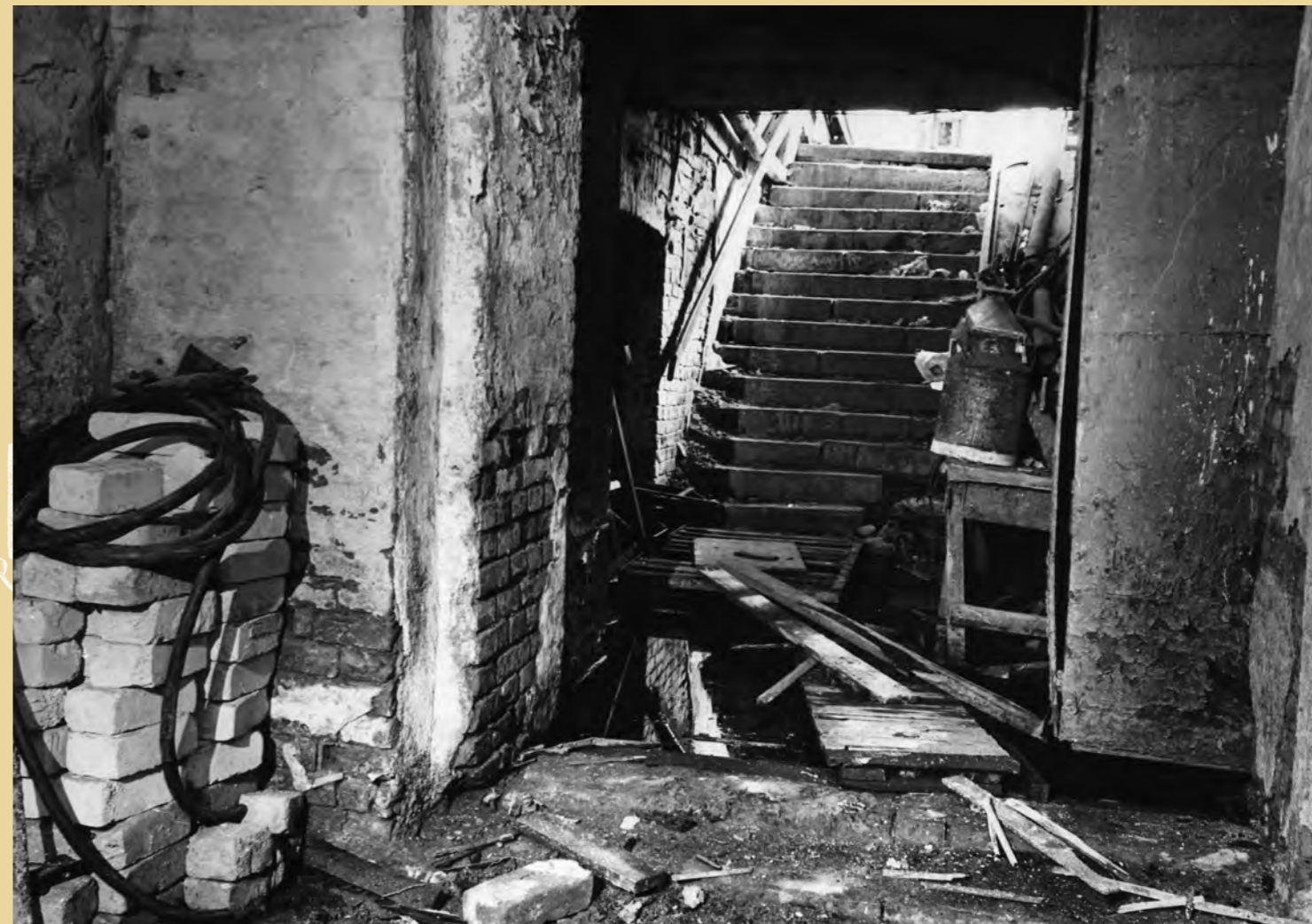
Так выглядел подвал с черного входа (со двора). 1987 г.
