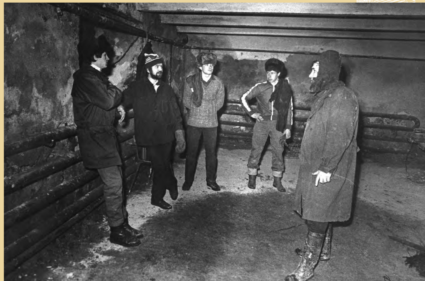
Подвал очищен. Теперь очередь строителей. 1987 г.
